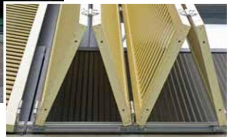
▼ MFH, Sonderanfertigung Faltschiebeläden Aluminiumvorhang mit HAWA-Frontfold 20
