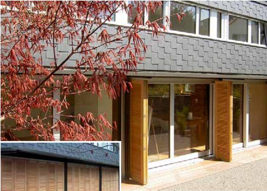
◀ EFH mit Faltschiebeläden, Classico f54 aus Lärchen Holz mit manueller Bedienung
