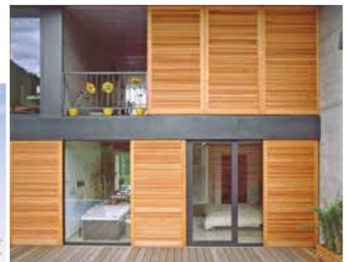
◀ EFH, Holzschiebeläden Classico f54, aus farblos imprägnierter Lärche mit unsichtbarer Führung oben und unten, partiell als feste Fassadenelemente.
